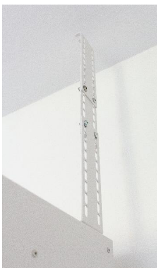
Infästning i tak från stativtopp
