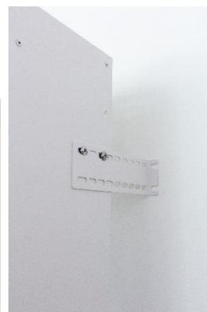
Infästning i vägg från stativsida
